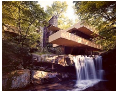
2B. Frank Lloyd Wright: Casa de la Cascada (1936-39).
